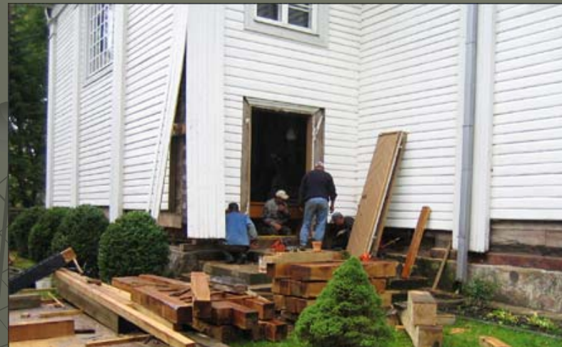
Pivašiūnai, bažnyčios restauravimas
